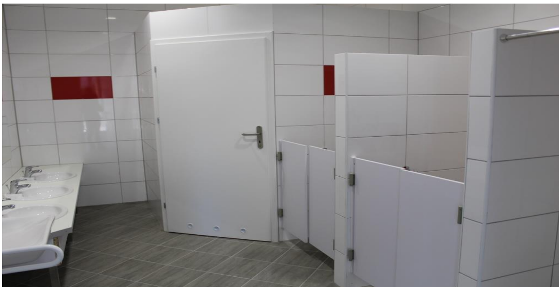
Fot. Publiczne Przedszkola w Damasławku- pomieszczenie higieniczno-sanitarne przy sali zajęć (źródło: strona internetowa placówki)
