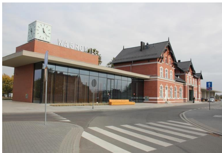
Dworzec kolejowy w Wągrowcu po modernizacji.
