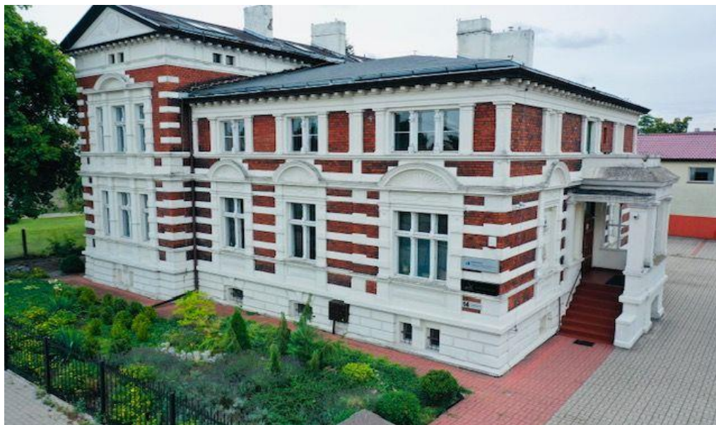
Fot. Budynek Niepublicznej Szkoły Podstawowej PROGRESSIO z Oddziałami Integracyjnymi w Wągrowcu (źródło: archiwum placówki)
