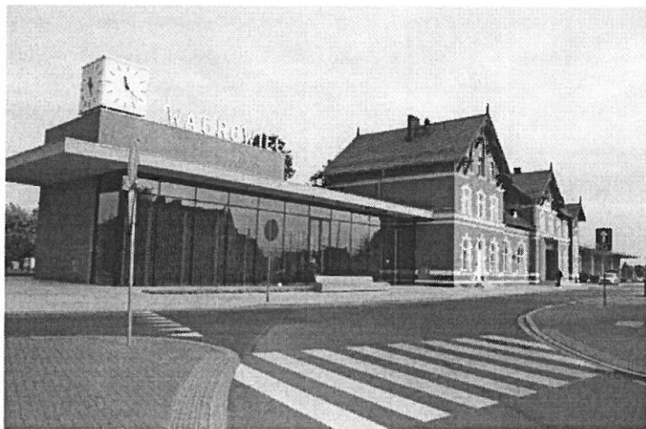
Dworzec kolejowy w Wągrowcu po modernizacji.
